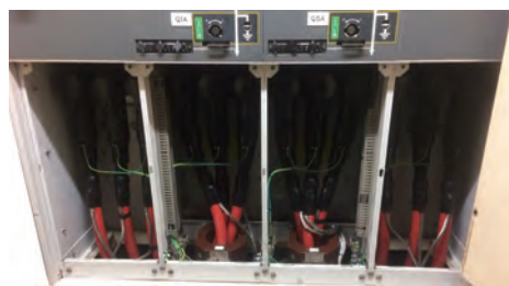
24kV, 630A T型电缆接头 (最大电缆截面积达400mm²)
