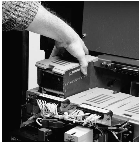
Fig. 13b Remove Arc Chute
