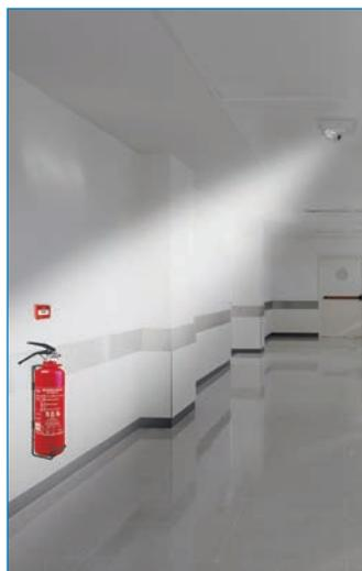
Beam tech sorgente luminosa molto intensa fornisce un'illuminazione efficiente per vie di esodo lunghe e strette, ma può anche fornire un'ampia copertura generale di un'area specifica quando sono posizionata a qualsiasi grado specificato l'una dall'altra, in luoghi dove l'illuminazione è richiesta un'illuminazione più forte.
