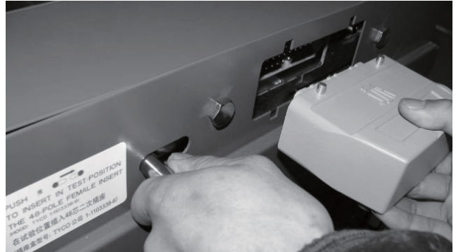
图 5.9 安装二次触头盒第一步
