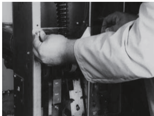
图6.7 把输入转角工具装入“A”孔
