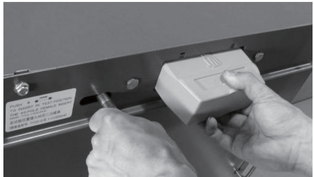
图 5.10 安装二次触头盒第二步
