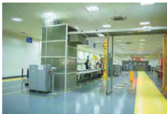
生产线在线安装
