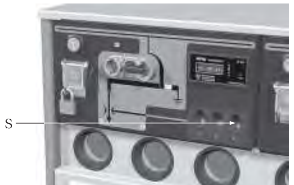
图32:电压检测器
