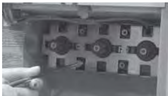
图35： 移开互感器和机架
