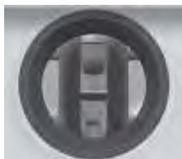
图16-2:隔离开关处于接地位置
