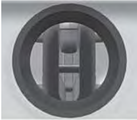
图20: 隔离开关在接地位置
