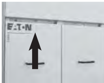
图10：打开电缆入口
