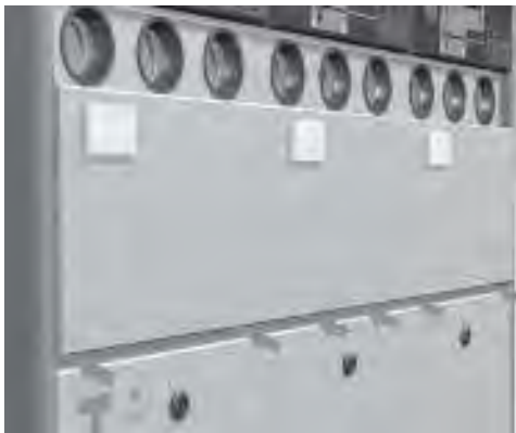
图14:前部盖板固定螺丝的位置
