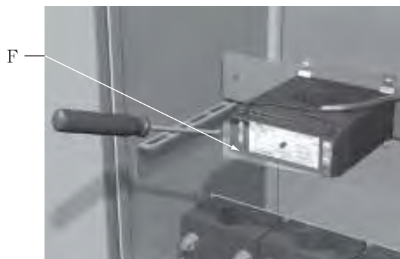
图42： 打开互感器塑料面罩
