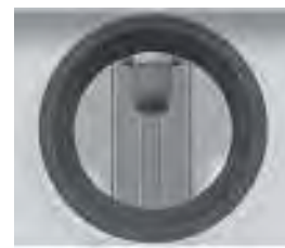
图16-4:隔离开关处于母线位置
