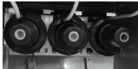
图25 移开互感器和机架
