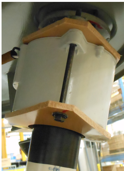
Figure 18. Transformateur de courant interne monté sur traversée
