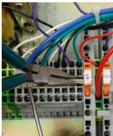
Figura 24. Retiro del puente entre C2 y C3.
