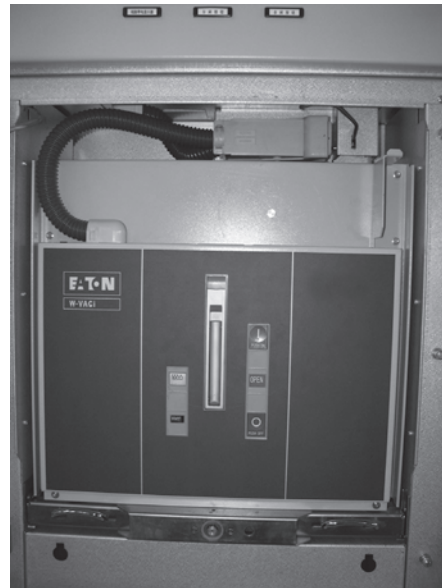
图8 断路器手车在试验位置
