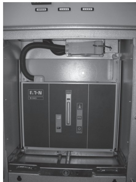
图9 断路器手车在工作位置
