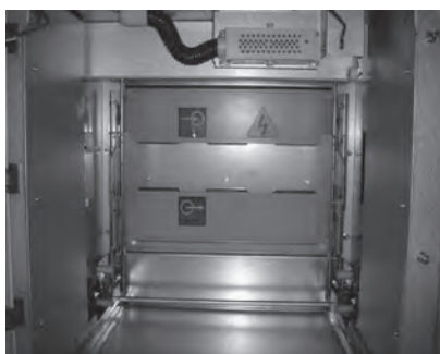
图3 断路器隔室内,上下活门关闭并遮蔽住一次触头
