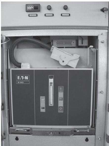
图7 断路器手车在断开位置
