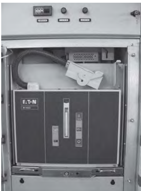
图7 断路器手车在断开位置
