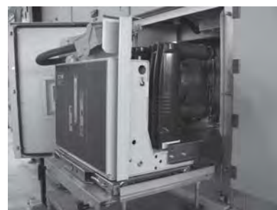
转运车与柜体锁定时可解除断路器手车与转运车的锁定装置，并将手车平稳推入柜体中
