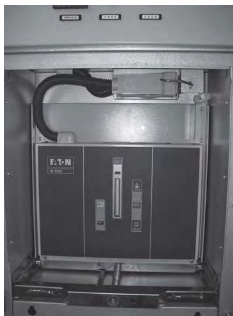
图9 断路器手车在工作位置
