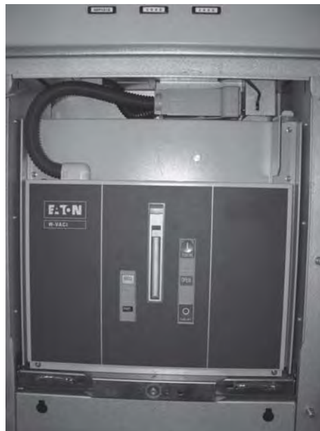
图8 断路器手车在试验位置
