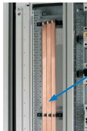
Gestufte Schienensysteme ermöglichen ein komfortables Anschließen der Abgangskabel
