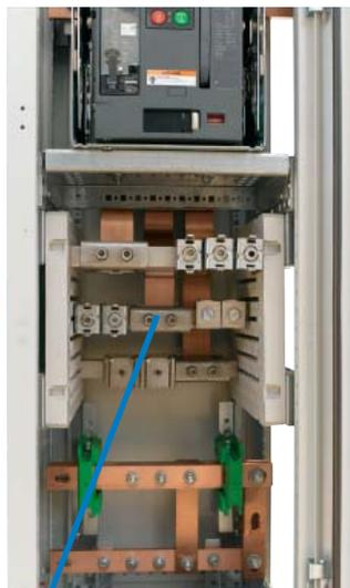
Bohrungsloses Kabelanschlussystem bietet Sicherheit und Komfort.
