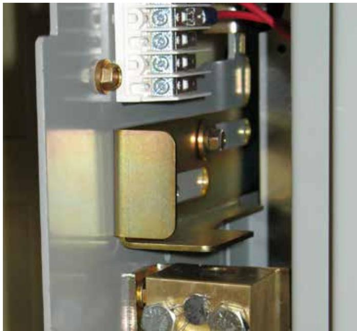
Figure 12. Système de verrouillage à clé pour cellule Magnum DS
