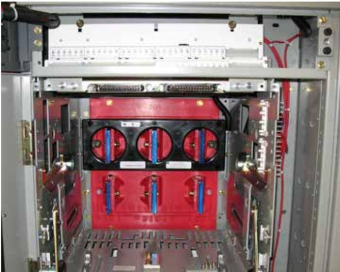
Figure 10. Bornes secondaires et transformateur de courant installés sur une cellule Magnum DS
