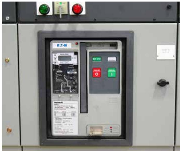
Figure 7. Disjoncteur Magnum DS (position connectée)
