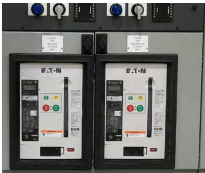
Figure 8. Disjoncteurs de la gamme NRX (position connectée)
