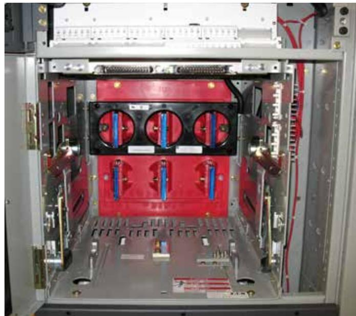
Figure 14. Bornes secondaires (installées sur une cellule) et transformateur de courant (installé sur une cellule) Magnum DS
