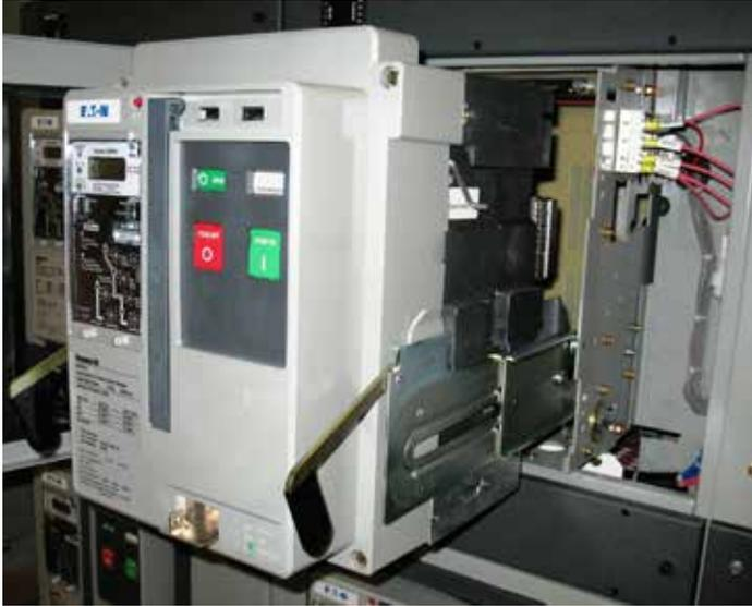
Figure 9. Disjoncteur Magnum DS sur des rails d'extension
