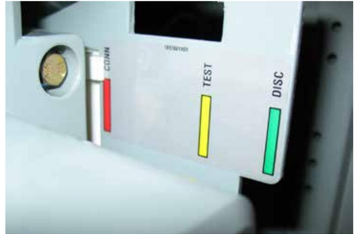
Figure 11. Étiquette de position du disjoncteur Magnum DS
