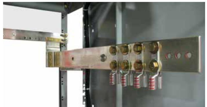
Figure 21. Extension de la barre omnibus de masse dans le compartiment des câbles (accessible par l'avant)
