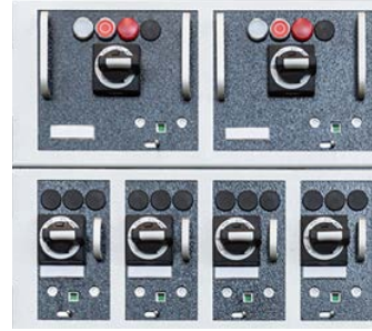
xEnergy Elite lades met hoge vulgraad, tot 32 x 18.5 kW starters per sectie
