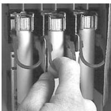
Extracteurs de fusibles intégrés (types 12 et 4X 30-200 A)
