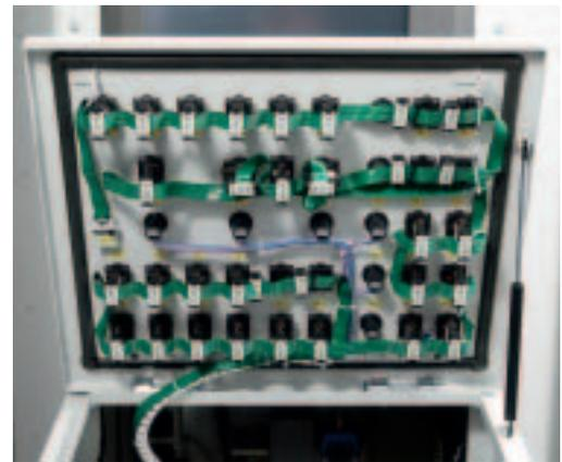
easy800 mit SmartWire-DT steuert Befehls- und Meldegeräte – einfach, schnell und effizient.
