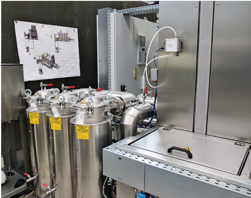
In der Reinigungsanlage der Schweizerischen Südostbahn sorgen drei einplätzig, parallelgeschaltete Beutelfiltergehäuse für gleichbleibend hohe Qualität des Waschwassers, das so viele Male wiederverwendet werden kann.
