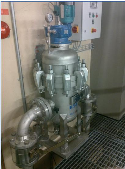
Abb. 2: Selbstreinigender Automatik-SiebkorbfILTER Modell 2596 von Eaton – hier Sonderausführung für Drücke von bis zu 100 bar
