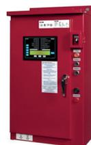
Se agregó en 2017; esta disposición NEC requiere que se instale un SPD Listado UL en el controlador de la bomba contra incendios para proporcionar protección. En un estudio encargado por la Fire Protection Research Foundation se encontró que el sistema eléctrico de 12% de los encuestados tenía sobretensiones que dañaban sus bombas contra incendios.
