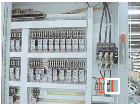
En la UL 508A, el PDB del circuito alimentador, 480 V, debe tener un espaciado de 1" a través del aire y 2" sobre superficie. Los PDB Listados UL, UL 1953, cumplen con estos requisitos de espaciado. Se debe verificar que los bloques de terminales Reconocidos UL, UL 1059, tengan el espaciado requerido.
