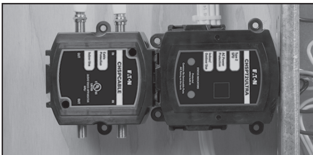
Figure 8. Joining CHSP Modules (1)/Jonction de modules CHSP (1)/Conexión de los módulos CHSP (1)
