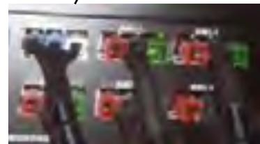
开关均选用行业3大著名品牌之一的伊顿品牌开关。配电模块后部全部预置与0U-PDU配合的连接端口，实现客户现场快速连接。
