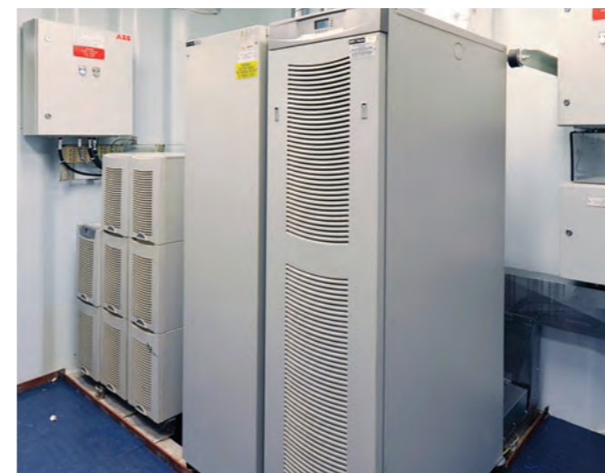
在“海洋绿洲号”上，伊顿船用型 UPS 为关键应用负载提供安全电力保护，使其免受断电影响
