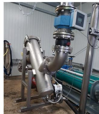
In der Kläranlage ersetzt der vollautomatische **MCS-500-Siebkorbfilter** eine manuelle Lösung, die das Betriebspersonal täglich mehrere Stunden Arbeit gekostet hat.
