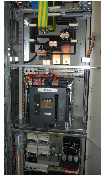
Les disjoncteurs IZM d'Eaton sont munis d'un dispositif de déclenchement électronique et d'une fonction de mesure intégrée.
