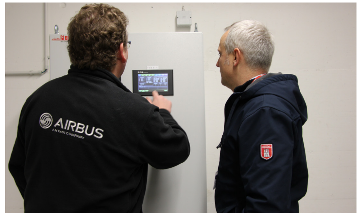
Le système BreakerVisu Eaton collecte toutes les données des disjoncteurs, du système de diagnostic pour la mesure de la température et du dispositif de protection contre l'arc interne ARCON pour les communiquer via Modbus directement au système de gestion du bâtiment.
