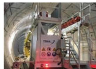
Eine perfekte Passform - die erste Bohranlage bohrt alle Löcher, die die Halterungen für Verkabelung, sowie die Geh- und Feuerwege aufnehmen werden. Die zweite Maschine fokussiert sich auf die Löcher für die Stromleitung, die die Crossrail-Züge mit Energie versorgen wird.
