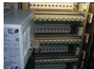
Eatons intelligentes Verdrahtungs- und Kommunikationssystem SmartWire-DT hat rund 80 Stunden Arbeit für die Erstellung der beiden Schaltschränke für die beiden Bohrfahrzeuge eingespart - dies umfasst die Verdrahtung, die E/A-Prüfung und die Inbetriebnahme.
