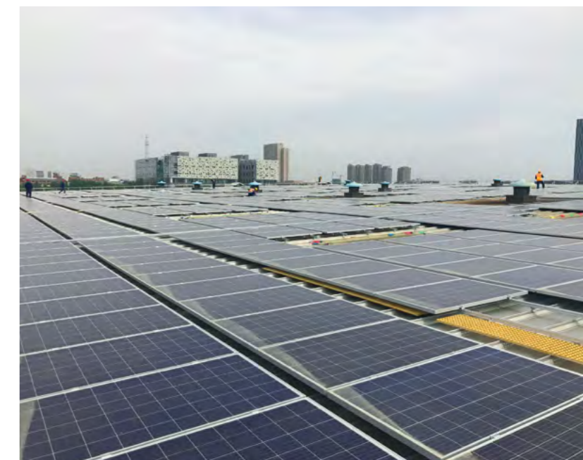
伊顿和南方电网综合能源公司展开战略合作，在伊顿中国的工厂推广开展新能源项目和使用节能减排技术。这些项目将帮助伊顿使用清洁能源，打造绿色工厂；项目中还使用了伊顿电气的相关产品。图为在伊顿济宁工厂屋顶铺设太阳能板
